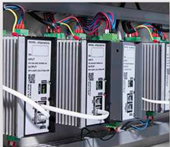
درايو اختصاصي به ازاي هر پوزيشن با قابليت اتصال به اينترنت special motor driver for each motor
